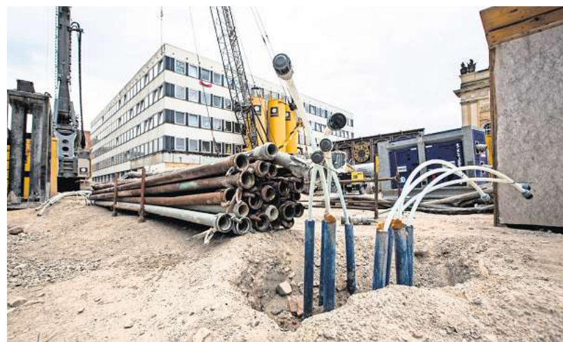
Auf der Baustelle der Garnisonkirche in Potsdam wird auch die MEB aktiv werden. ARCHIVFOTO: FRIEDRICH BURGERT
