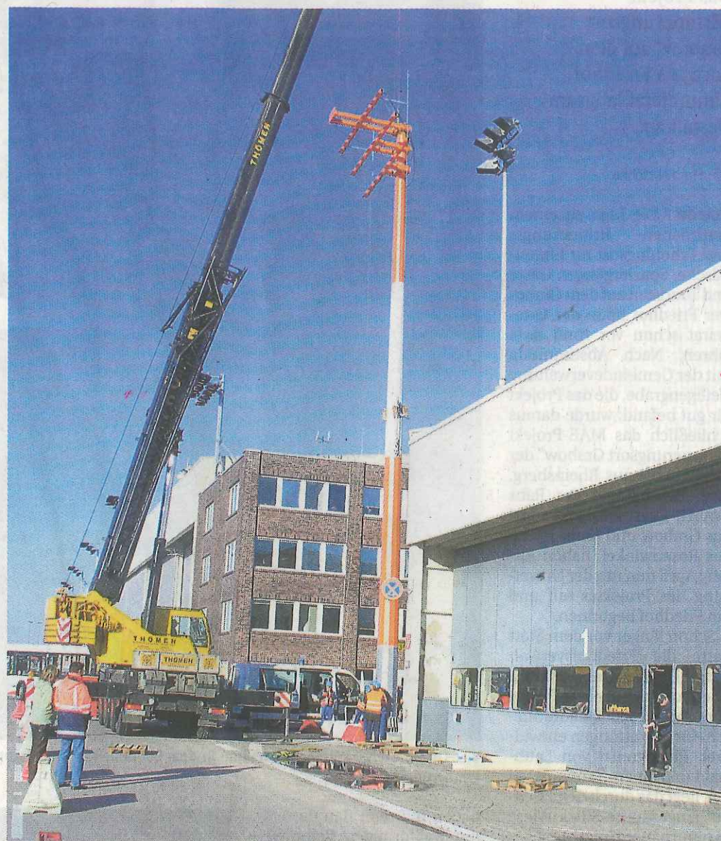
Meyenburger MEB-Mitarbeiter installieren die Beleuchtung auf dem Hamburger Airport.
